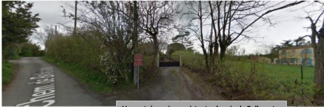
Vue entrée maison existante chemin de Bellecoste
