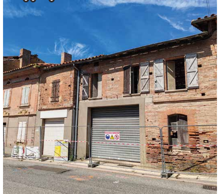
Démolition des garages de l'îlot 24
