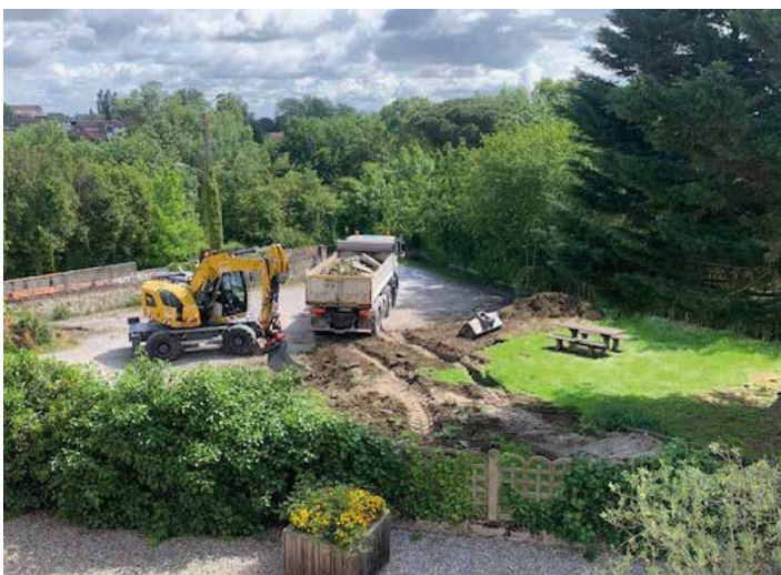
Début des travaux à la mairie
