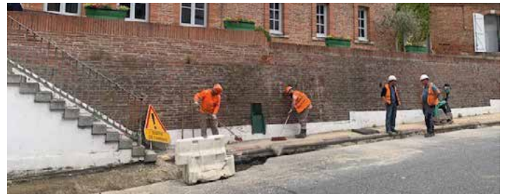
Travaux pour l'alimentation en eau potable
